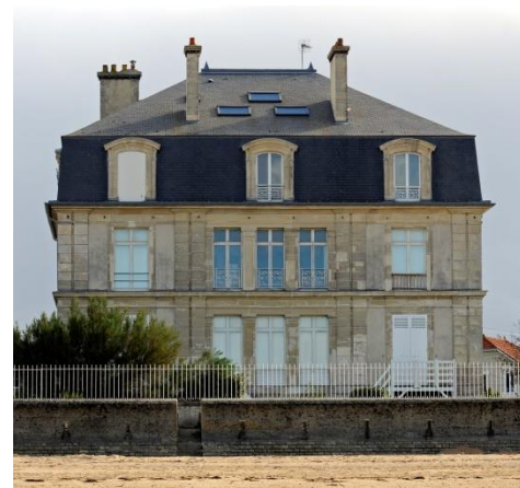
La Maison carrée
